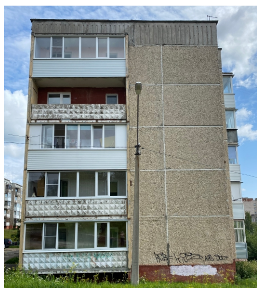
Боковой фасад со стороны ул. Южная
