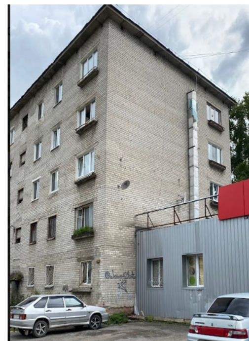
Боковой фасад со стороны ул. Ломоносова
