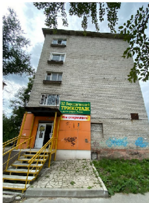
Боковой фасад по ул. Парижской Коммуны
