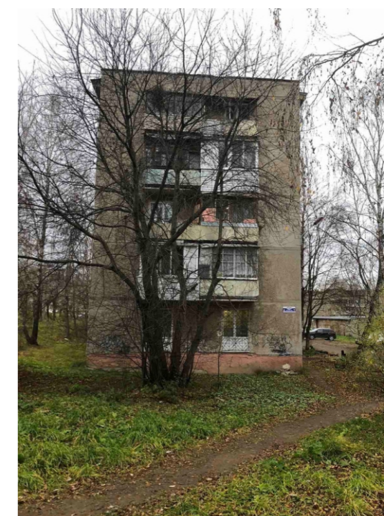
Боковой фасад со стороны двора
