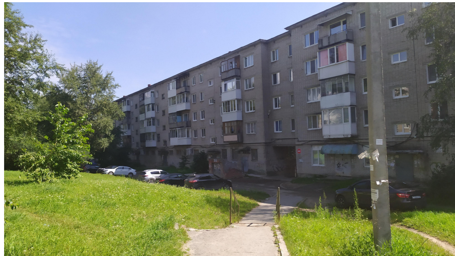
Вид на дворовой фасад
