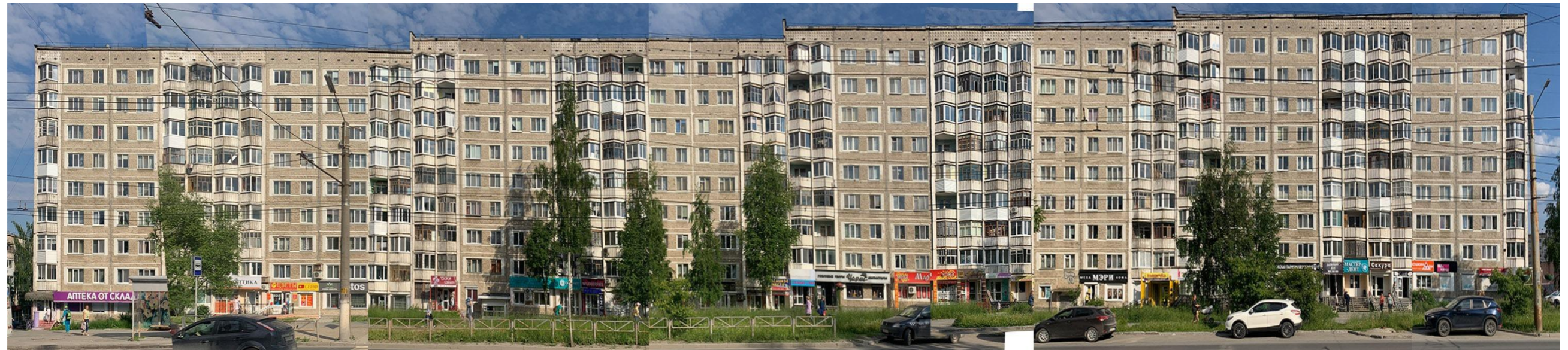
Главный фасад по ул. Мира
