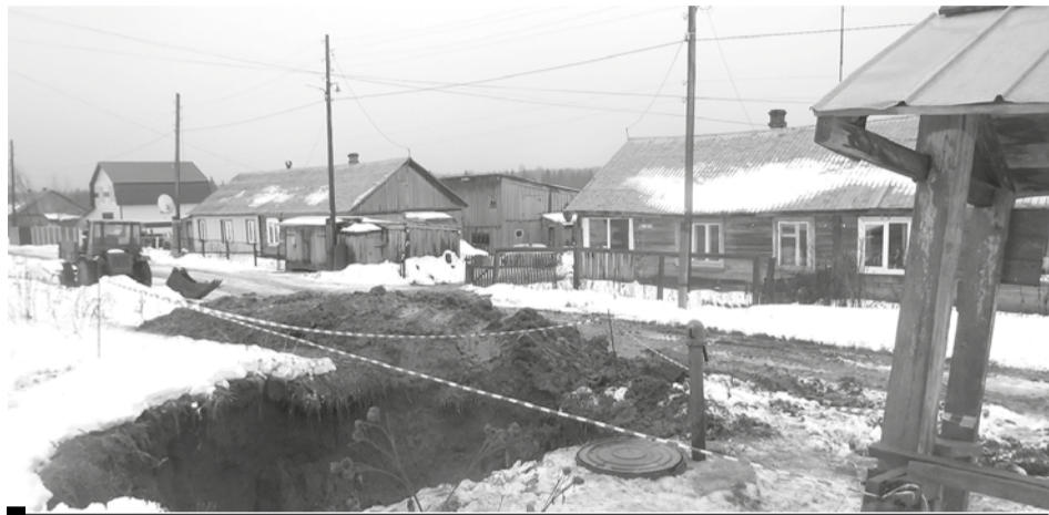
Ремонт водопровода в с.Берёзовка. Весна 2020 г.
