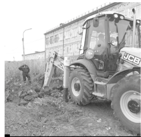
Ремонт водопровода в с. Пыскор.
