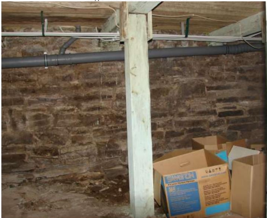
Интерьер подвала. Фото 2007 г.
