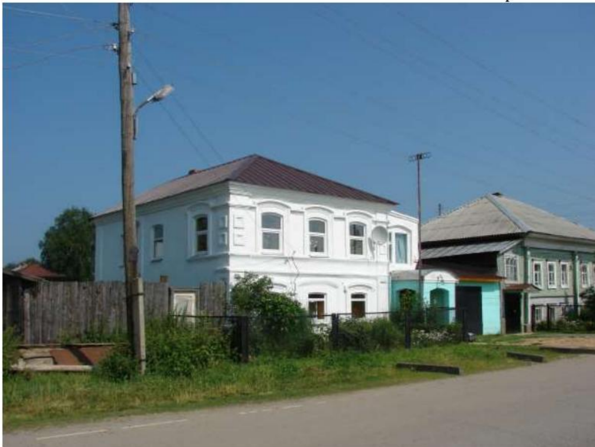
Общий вид с юга. Фото 2007 г.
