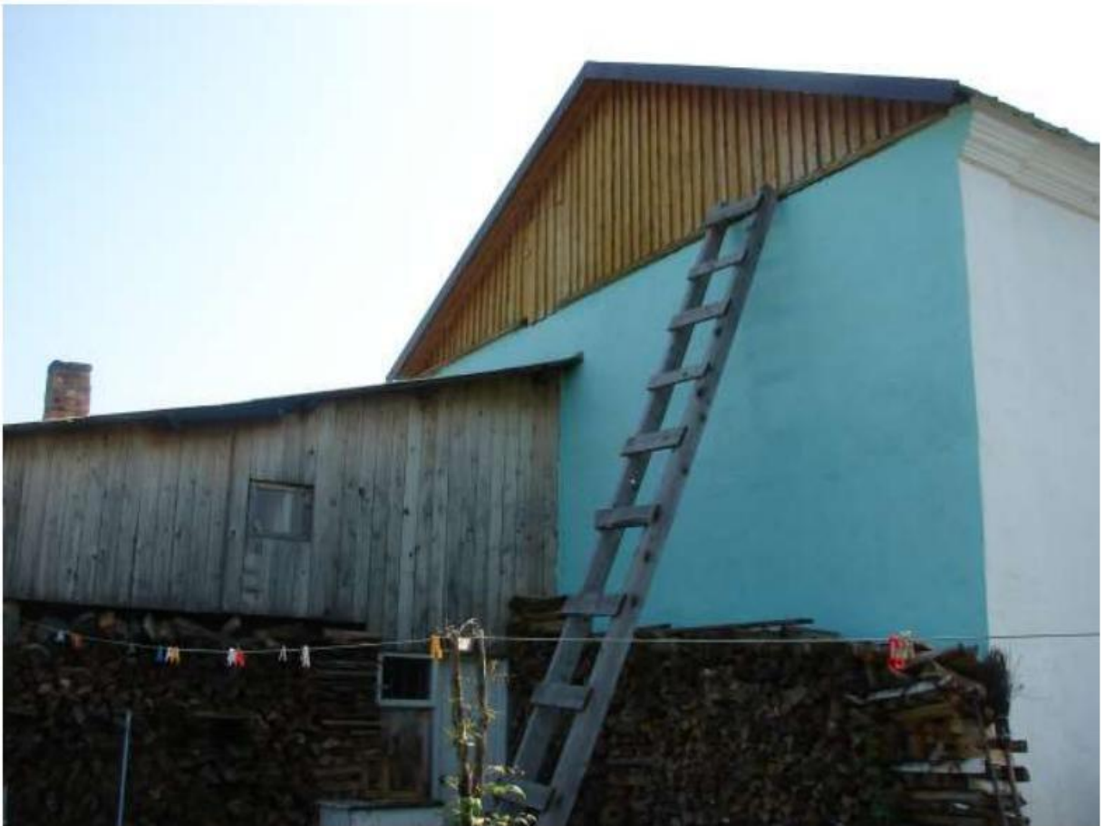
Вид с северо-запада. Фото 2007 г.
