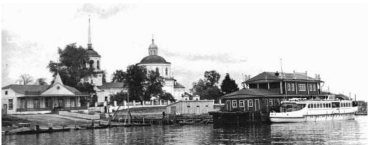
Вид с юга. Фото 1966 г.
