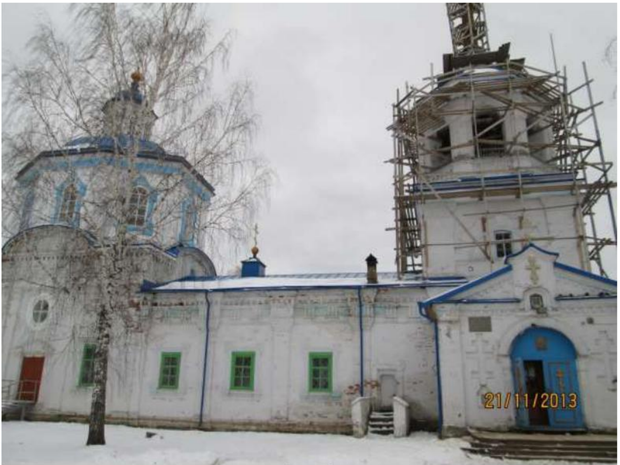
Северный фасад, фото 2013 г.
