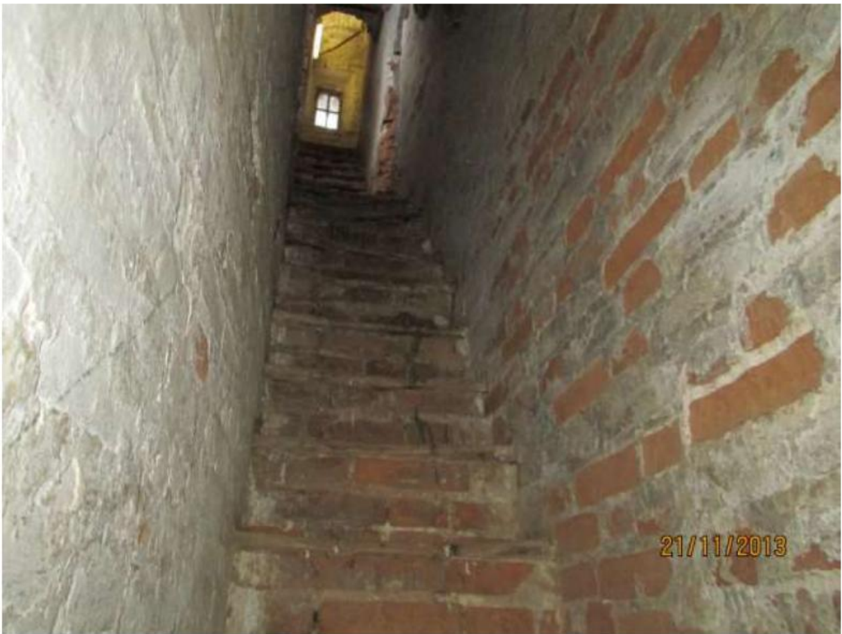
Внутрстенная лестница на колокольню. Фото 2013 г.
